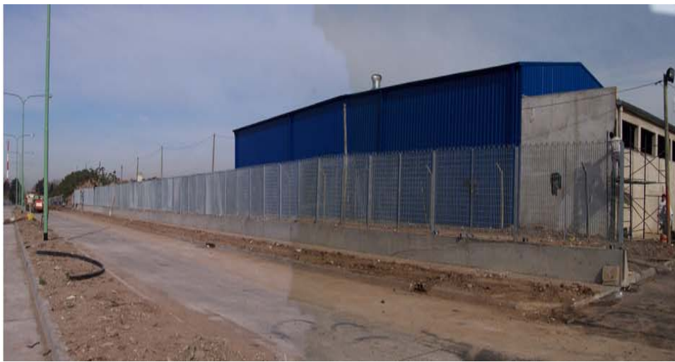
LADO A (LATERAL ACCESO)
