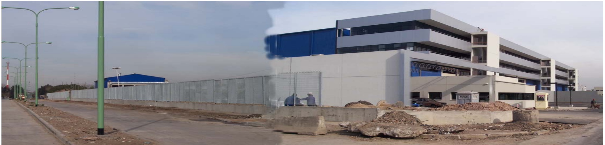
LADO A (LATERAL ACCESO)
